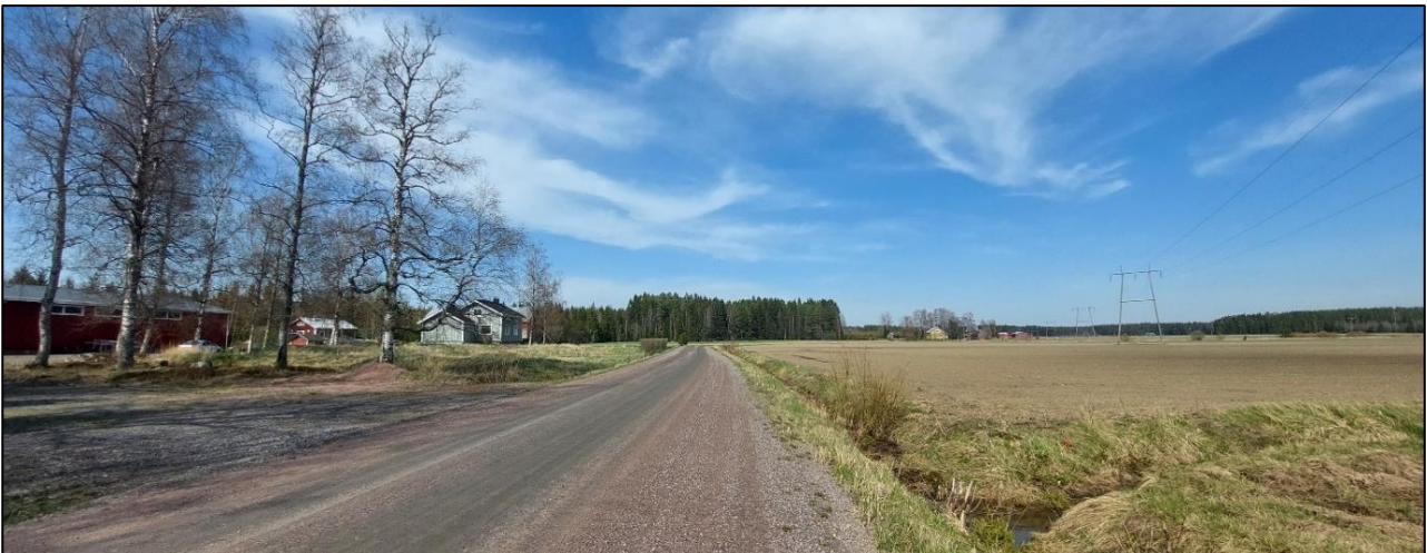
Kuva 39. Loimaan Kanniston ja Koiviston alueella voimajohtoreitti erottuu peltoaukealla selkeästi. Kuva on otettu Koskenraitilta voimajohtoreitin suuntaisesti koilliseen.
