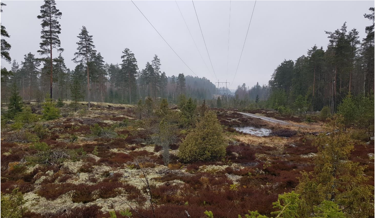
Kuva 4. Voimajohtolinja halkoo monia kallioisia alueita kosteikkojen välissä, kuvassa Loimaan (ent. Alastaro) Ristinkalliolta etelään kulkeva linja.
