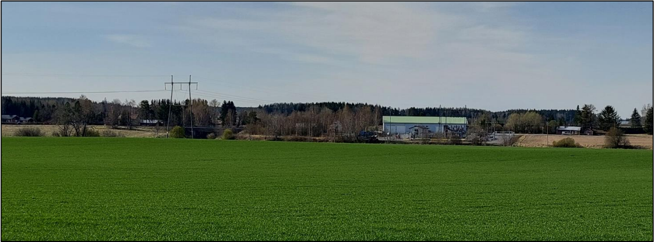
Kuva 38. Loimaan Alastaron Loimijoen peltoaukea ja Niinijoensuun sähköasema. Kuva on otettu Vuolle-Suutarlantieltä etelän suuntaan.
