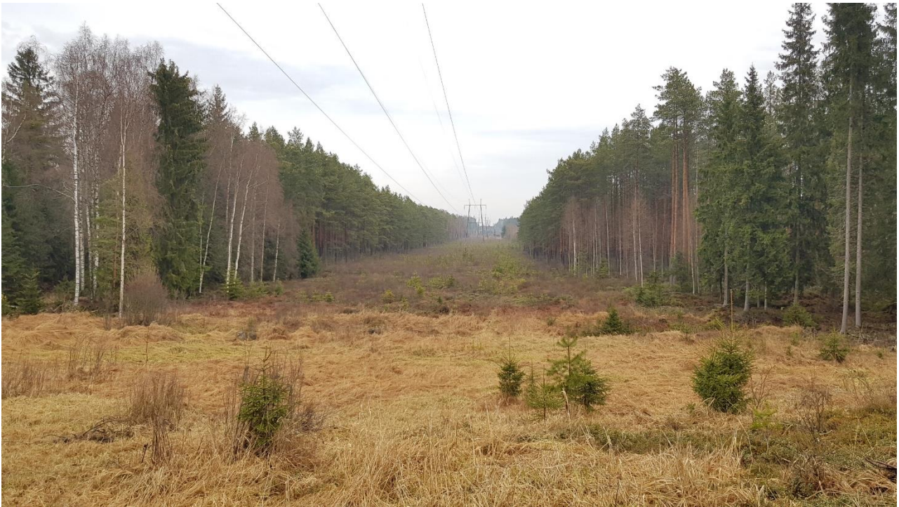
Kuva 3. Voimajohtolinjan kulku Punkalaitumen Arkuinsuon pohjoisosan halki. Kuvattu lounaasta.
