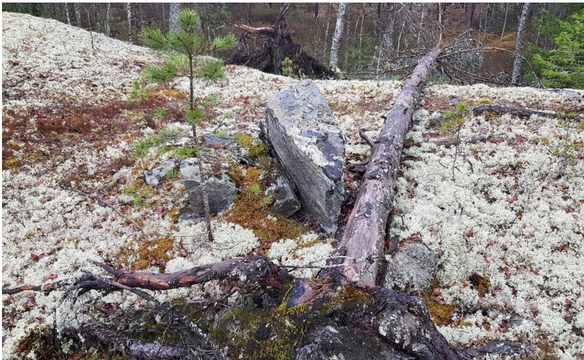
Kuva 10. Valkeiskallion rajapyykin viereen kaatunut puu on voinut rikkoa kivirakennetta. Kuvattu lännestä.
