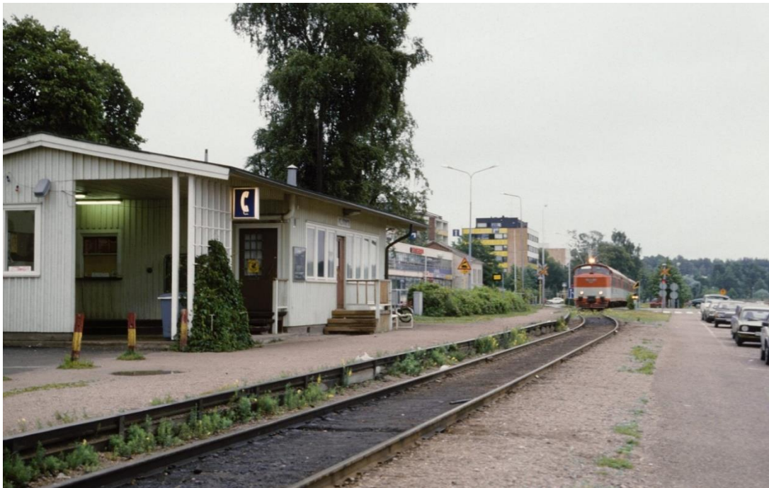
Kuva 2. Moottorijuna saapumassa Kalarannan seisakkeelle. Seisakelaituri on hiekkapintainen sekä reunaltaan pääosin ratakiskoista toteutettu. Laituri on noin kahden vaunun mittainen. Asemarakennus palvelee matkustajia, muun muassa lipunmyynti, odotustila, WC ja yleisöpuhelin kuuluvat tarjontaan. Kalaranta, 13.7.1984. Kuva: Tapio Keränen.
