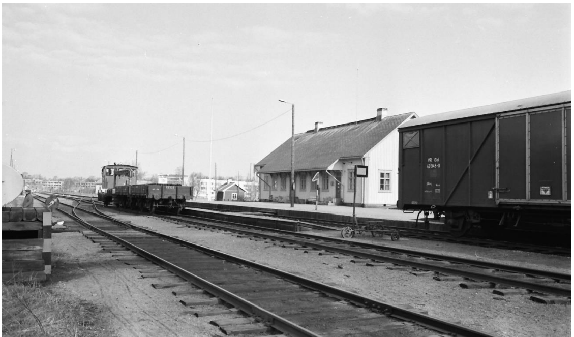
Kuva 4. Uudenkaupungin pääaseman pääraiteen paasikivireunaisen laiturin lisäksi asemalle oli toteutettu välilaituri. Kulku välilaiturille tapahtuu laituripolun kautta. Laituri on rakenteeltaan pääosin viisto, vain toisen raiteen puolella on varsinainen reuna, toiselta puolelta laituri laskeutuu ratapihan tasolle. Uusikaupunki, 29.4.1974. Kuva: Tapio Keränen.
