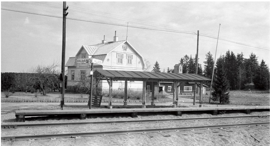
Kuva 6. Tyypillinen Uudenkaupunginradan seisake Vallaisissa. Betonianturoille perustettu suurehko odotuskatos on seisakkeen vierellä. Puisen seisakelaiturin rakenne on vastaava kuin Rahkmalassa, suoraan ratapohjan päälle perustettujen pölkkyjen päälle on rakennettu kansilankutus. Vallainen, 29.4.1974. Kuva: Tapio Keränen.
