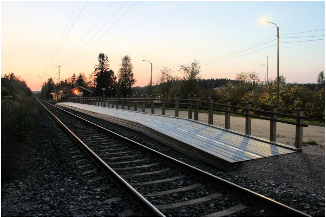
Kuva 4. Alueellisen junaliikenteen kevytrakenteisen seisakelaiturin toteuttamista kokeiltiin Sipoon Nikkilässä puurakenteisella 45 m pituisella koelaiturilla. Laituriratkaisulla selvitettiin puurakenteisen laiturin rakentamisen toimintatapoja ja kustannuksia, kokeilu liittyi myös valtion puurakentamishjelmaan. Laiturin korkeudeksi valittiin 40 cm, sillä se on lähellä duoraitiovaunujen tavanomaista laiturikorkeutta ja soveltuu myös rataosan museoliikenteessä käytetyn Dm7-kaluston astinlautojen korkeudelle. Nikkilä, 27.9.2020. Kuva: Aarne Alameri.
