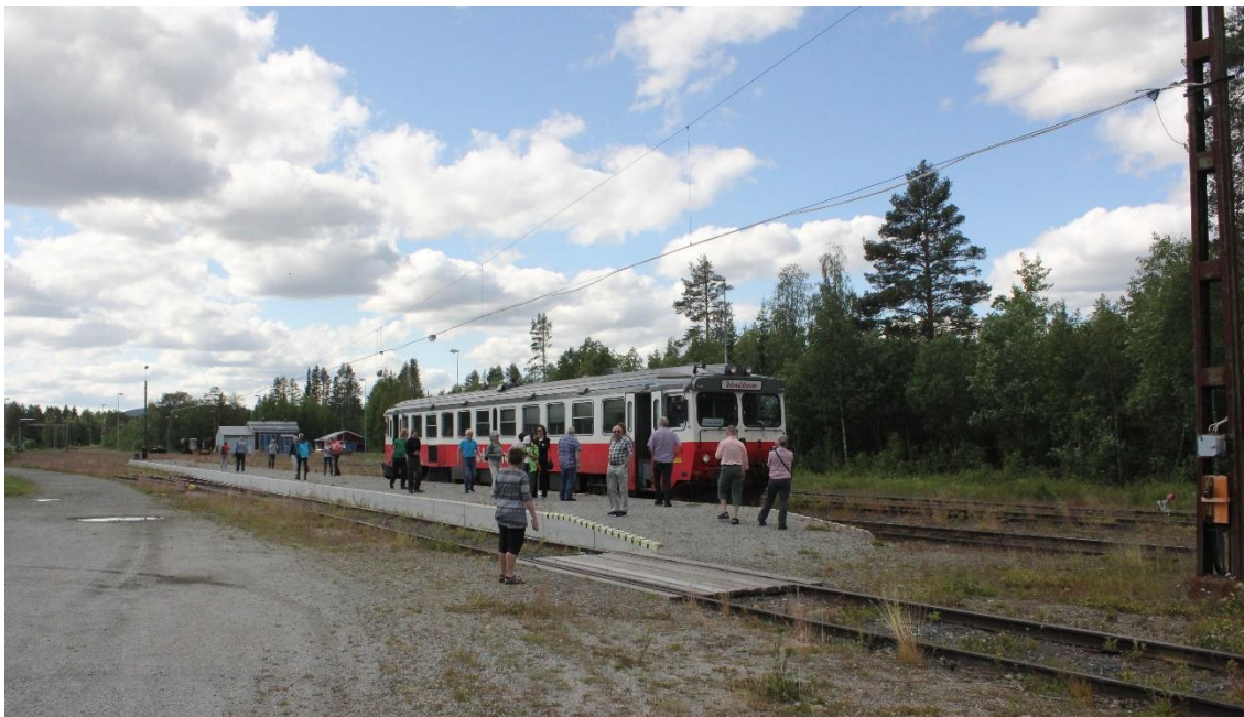
Kuva 15. Hotingin asemalle on toteutettu laituripolku sekä reilun kahden vaunun mittainen asemalaituri. Asemalaiturin reunat ovat betonielementeistä ja laiturin on hiekkapintainen. Laiturin kunnossapidon helpottamiseksi valaistus ja kuulutuslaitteet ovat vaijeriripustuksella, jolloin laiturilla ei ole kiinteitä rakenteita. Inlandsbanan liikenteestä pääosa on moottorivaunuin operoitua liikennettä, mutta pidempi laiturin mahdollistaa myös sesonkiliikenteen junille mahdollisuuden pysähtyä siten, että pitkistä junasta neljässä vaunussa molemmat tai toinen ovista mahtuu laiturisiin. Hoting, 9.7.2019. Kuva: Aarne Alameri.
