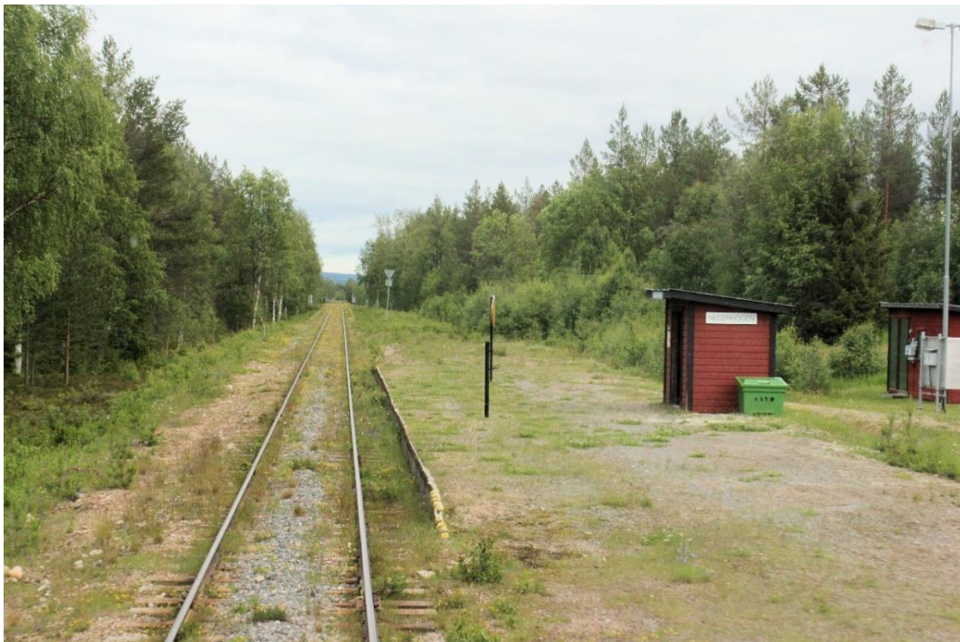
Kuva 19. Nederhögenin seisake on Ruotsissa Inlandsbanalla Moran ja Brunflon välisellä rataosalla. Seisake on yhden vaunun mittainen. Seisakealue on valaistu ja sillä on puurakenteinen odotuskatos. Liikennöinti perustuu yhden tai kahden moottorivaunun junayksiköihin. Jos seisakkeelle on molemmista yksiköistä poisjääviä matkustajia, pysäytetään yksiköiden keskimmäiset ovet laiturin kohdalle ja ohjataan matkustajat käyttämään näitä ovia. Nederhögen, 7.7.2019. Kuva: Aarne Alameri.
