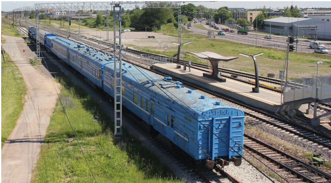
Kuva 17. Vessen seisake sijaitsee Tallinnan ja Aegviidun välisellä rataosalla. Seisakkeen uudelleenrakennuksen yhteydessä siitä tehtiin ainoastaan yhden vaunun mittainen. Junien matkustajainformaatiolla kerrotaan, mikä osa junasta palvelee lyhyitä seisakkeita, muissa vaunuissa ovet pysyvät lukittuina. Esteetön yhteys laiturille kulkee kadulta ylikäytävän kautta. Toinen yhteys seisakkeelle on sillalta, jonne ei ole esteetöntä yhteyttä. Vesse, 19.6.2013. Kuva: Aarne Alameri.
