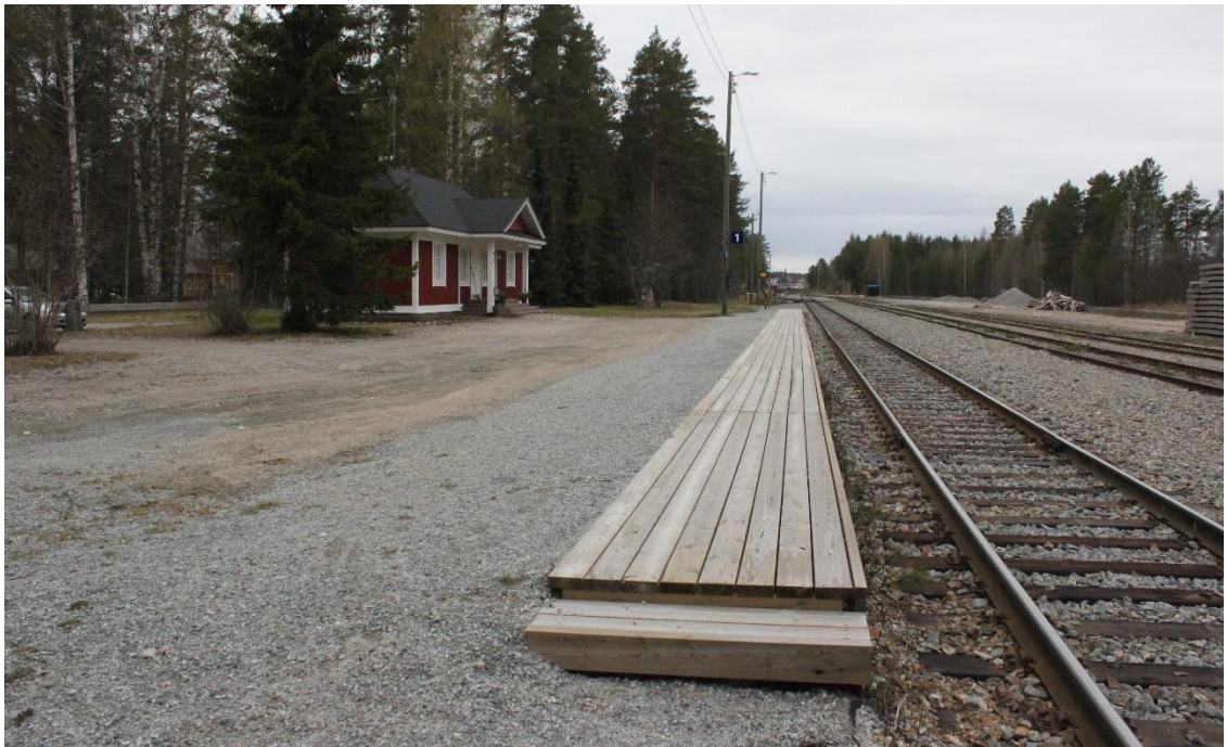
Kuva 7. Höljäkan asema. Aseman laiturin edustaa perinteistä paikallisliikenteen laituria, joka on rakenteeltaan yksinkertainen ja kulkuyhteyksiltään esteetön. Laituri on pääosin maa-aineksesta ja vain reunaltaan puurakenteinen. Ratkaisulla varmistetaan laiturin riittävässä asennustoleranssissa pysyminen suhteessa raiteen keskiliinjaan. Laiturin kansilankutus oli uusittu hiljattain. Laiturin pituus on 60 m. Höljäkä, 16.5.2015. Kuva: Aarne Alameri.
