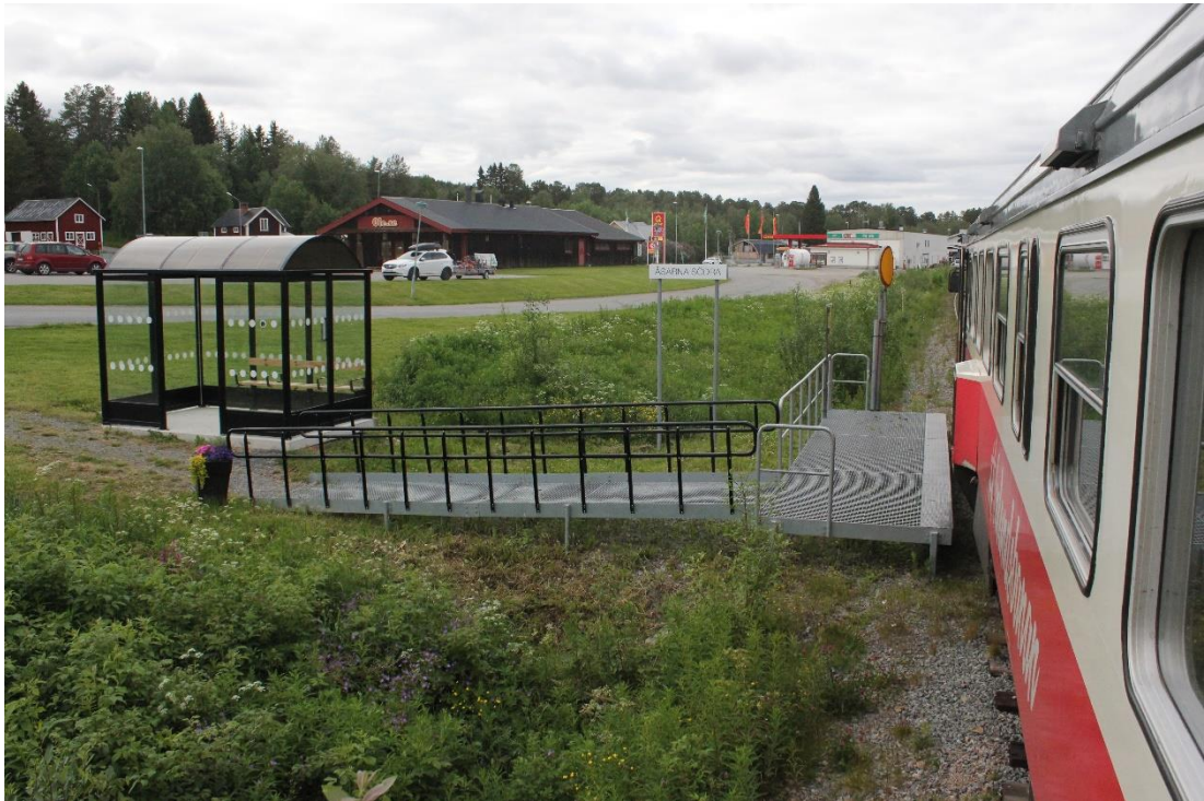
Kuva 21. Åsarne Södran seisake Ruotsissa Inlandsbanalla Moran ja Brunflon välisellä rataosalla. Esteetön ritilärakenteinen laiturin on 7,2 m pituinen. Laiturille johtava ramppi on suurin piirtein saman mittainen. Laiturin reunassa on kontrastireuna sekä kaitteet eri sivuilla. Seisakkeelle johtavan rampin vieressä on tavanomainen betonilaatalle perustettu bussipysäkkikatos. Y1 moottorivaunuja käytettäessä vaunun toinen ovi pysähtyy laiturin kohdalle tai kahden vaunun liikenteessä yksikköjen keskimäiset ovet. Seisakkeen toteuttamiskustannukset ovat olleet hyvin huokeat. Laiturielementtien kokonaishinta oli 75.000 SEK sekä pysäkkikatoksen 75.000 SEK. Laiturin asennuskustannus oli 50.000 SEK sekä pysäkkikatoksen 25.000 SEK. Kokonaiskustannus oli yhteensä suunnittelu huomioiden noin 225.000–250.000 SEK [Portinson 2020] eli noin 22.080–24.540 euroa maaliskuun 2021 valuuttakurssilla.
