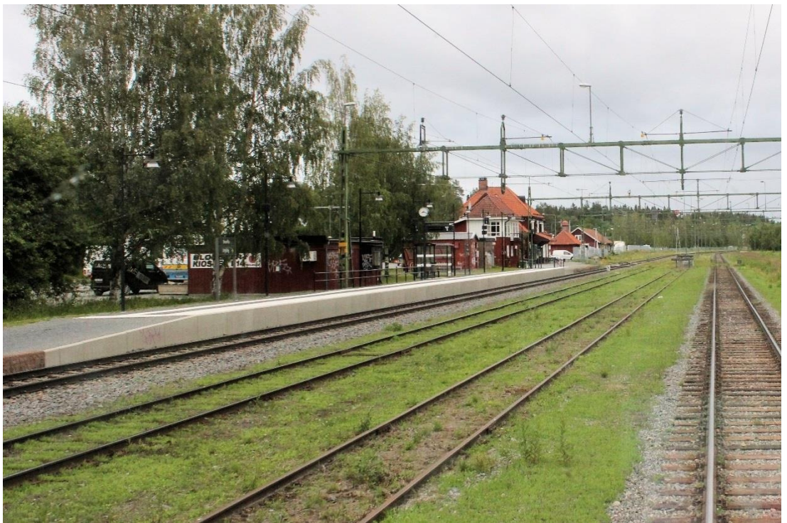
Kuva 11. Ången ja Östersundin välisellä rataosalla sijaitseva Brunflo asema, jolla laiturin on toteutettu osittain korkeana. Muutaman vaunun mittainen korotettu osuus varmistaa esteettömän yhteyden junien palveluvaunuihin. Pitkissä junissa osa vaunuista pysähtyy matalalle laiturin osalle. Brunflo, 7.7.2019. Kuva: Aarne Alameri.
