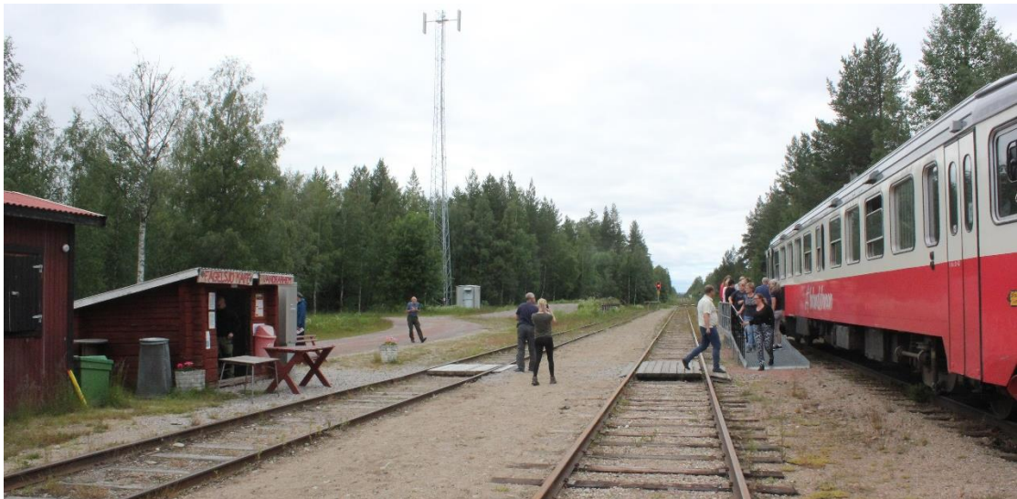
Kuva 23. Fågelsjön seisake sijaitsee Ruotsissa Inlandsbanalla Moran ja Brunflon välisellä rataosalla. Ritiärakenteinen laiturilla on periaatteiltaan vastaava kuin Åsarna Södralla, paitsi esteetön ramppi laiturille on raiteen suuntaisesti. Laituri sijaitsee ratapiharaiteiden välissä, sillä pääraide on kauimpana asema-alueesta. Kulku laiturille tapahtuu laituripolun kautta. Tilanahtauden vuoksi odotuskatos on sijoitettu ratapihan reunalle. Fågelsjö, 7.7.2019. Kuva: Aarne Alameri.
