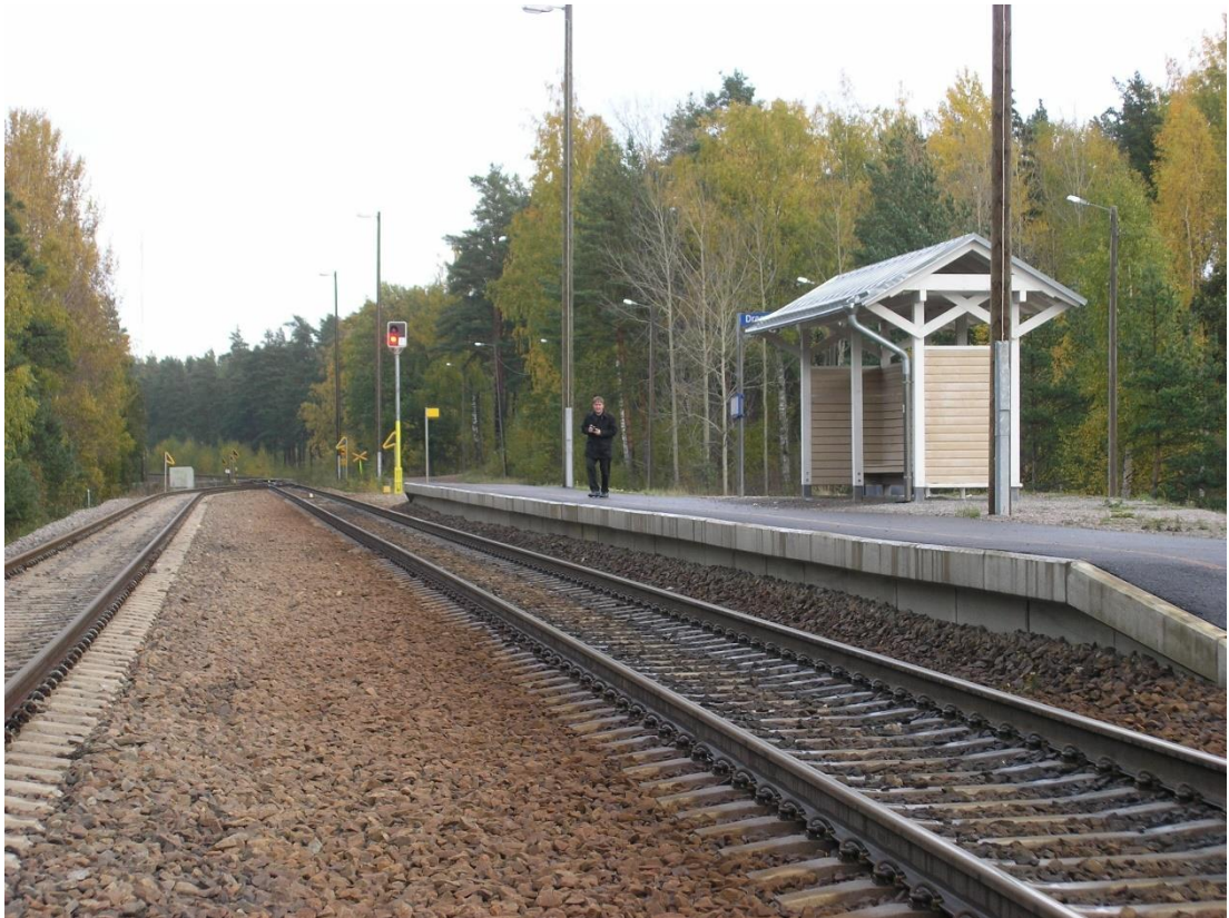
Kuva 26. Dragsvikin asfalttipintainen ja betonielementtireunainen seisakelaituri. Laiturin perusrakenne vastaa tässä työssä esitettävää mallia. Dragsvik, 7.10.2004. Kuva: Antero Alku.
