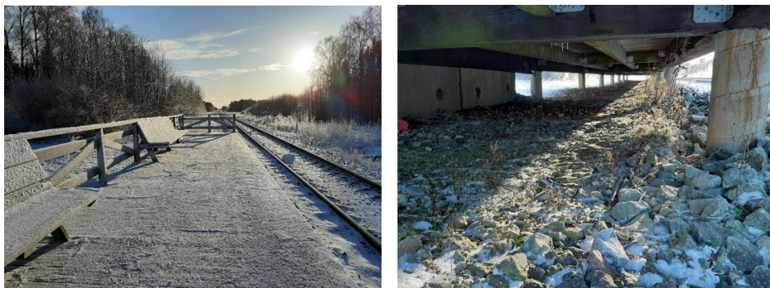
Kuva 17. Puupintarakenteinen betonipilareille perustettu laiturirakenteena kuvattuna Viron rautateillä. Kuvat: Maunu Tast.
