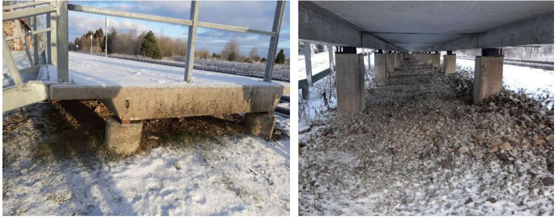
Kuva 18. Betonisen laiturin toteutustapa Viron rautateillä. Kuvat: Maunu Tast.
