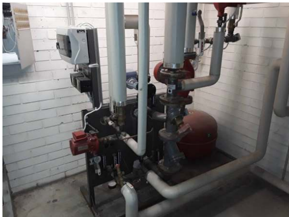
104. Lämmönjakokeskus.
