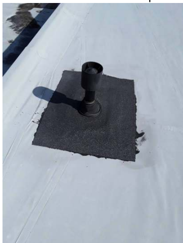
75. Paikkauksia tehty huovalla
