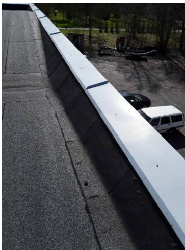
81. Korkean halliosan katto uusittu
