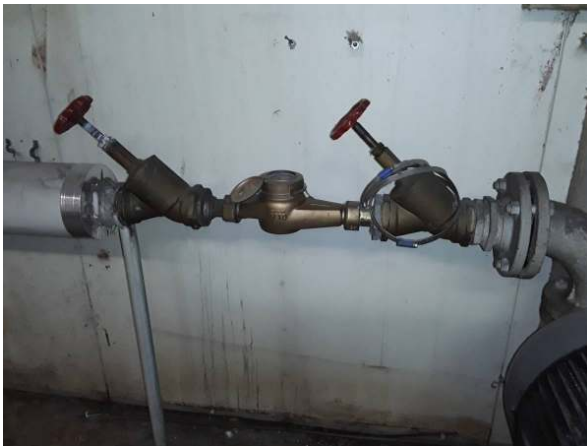
117. Kiinteistön päävesimittari.
