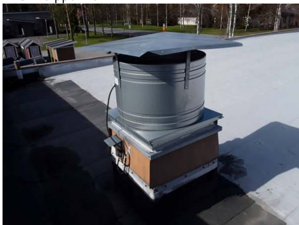
131. Huippuimuri uusittu 2012.
