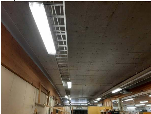
164. Sisätilojen valaistusta. Puutyö.
