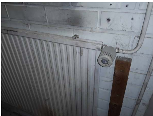
113. Termostaattinen patteriventtiili.
