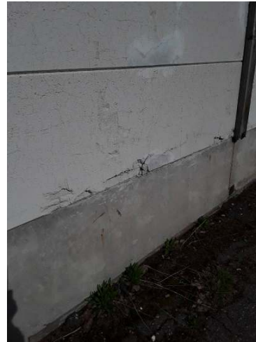
51. Siporex-elementtien tukipuut lahoja
