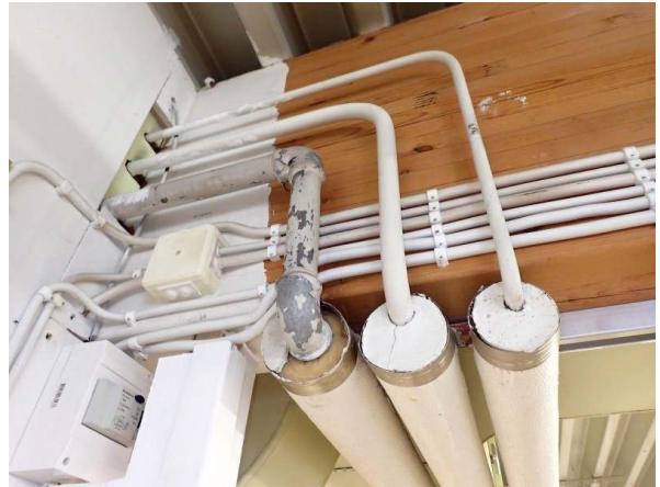
128. Putkieristeet saattavat sisältää asbestia.
