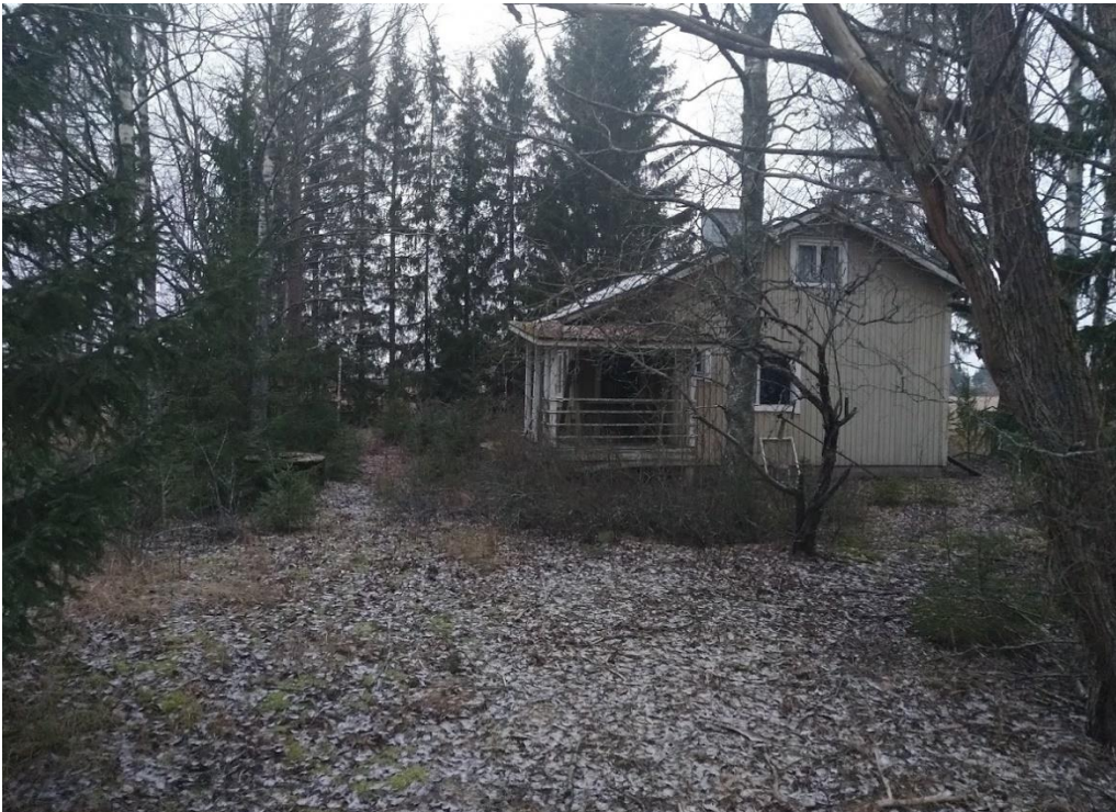
Kuva 4 - Kuva 30.11.2020 Lähteenmäentieltä kohti länttä, kaivo ja rakennus
