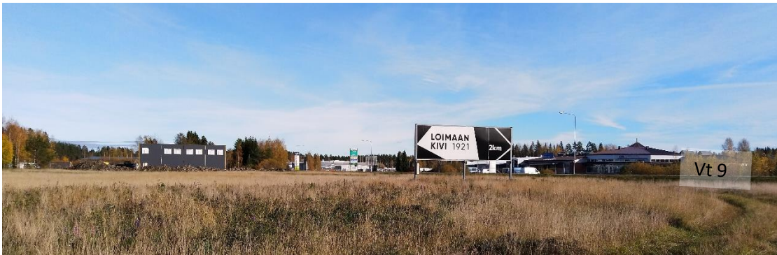
Kuva 10 – Suunnittelualueella rakenteilla oleva yritysrakennus ja vt 9:n toisella puolella sijaitseva Loimaan Laatuauto Oy, kuva 10/2020
