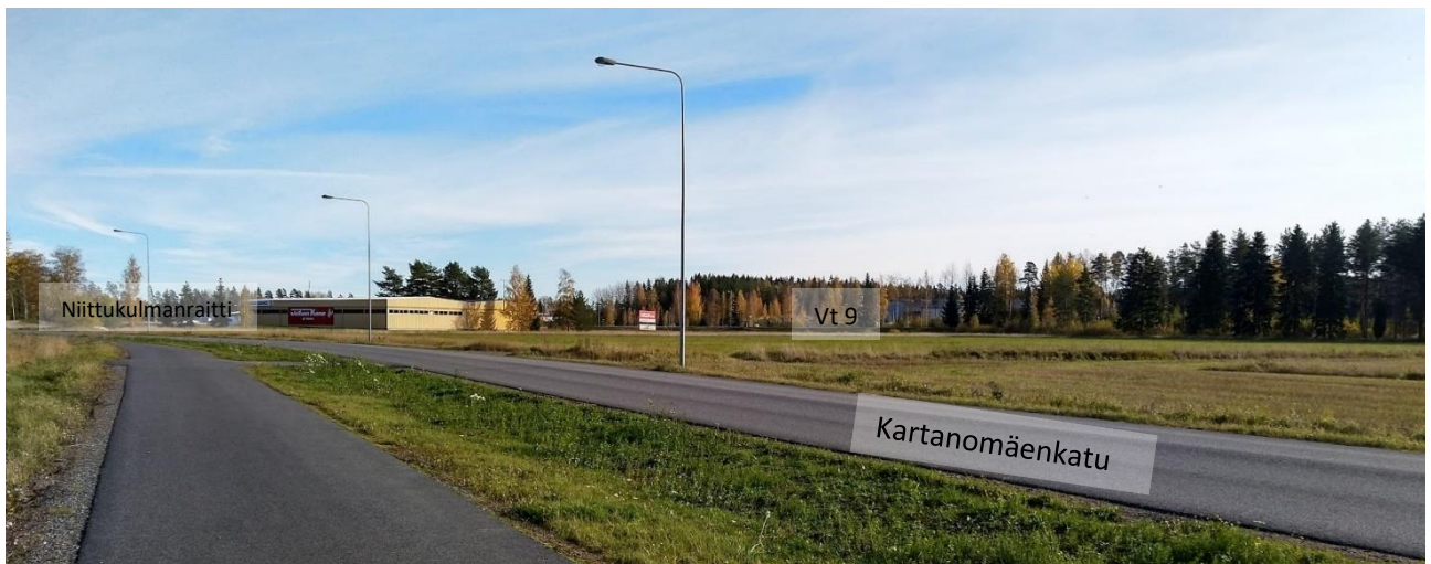
Kuva 8 - Näkymä kaakkoon 10/2020, Loimaan Sähkö
