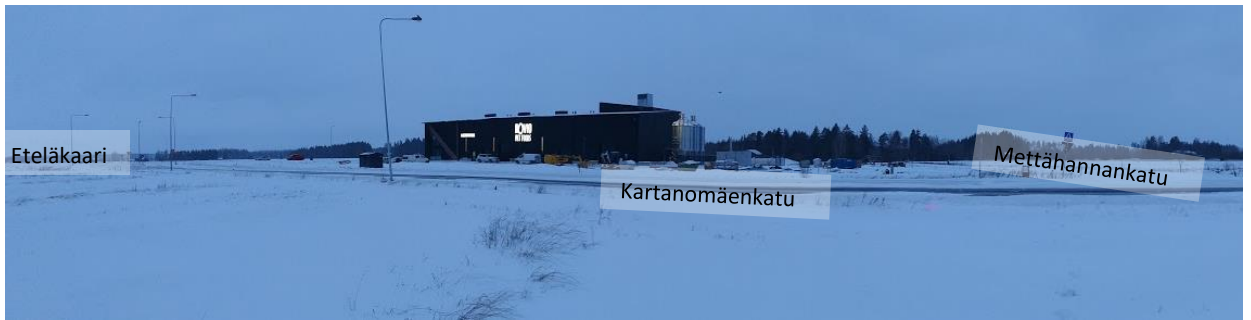
Kuva 7 - Näkymä pohjoiseen 1/2021, Rovio Pet Foods
